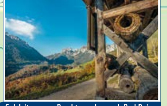
Soleleitung von Berchtesgaden nach Bad Reichenhall, 25 km lang, 1817, Georg von Reichenbach
